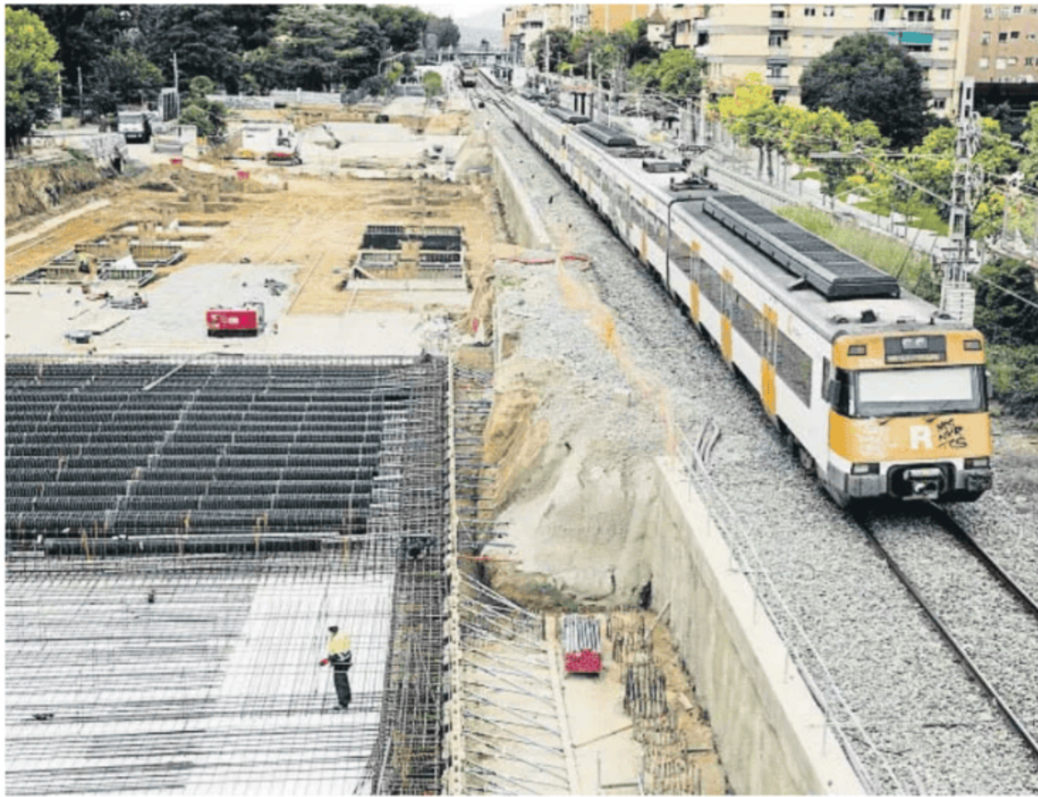
Un tren de Rodalies pasando al lado de las obras del soterramiento del ferrocarril
