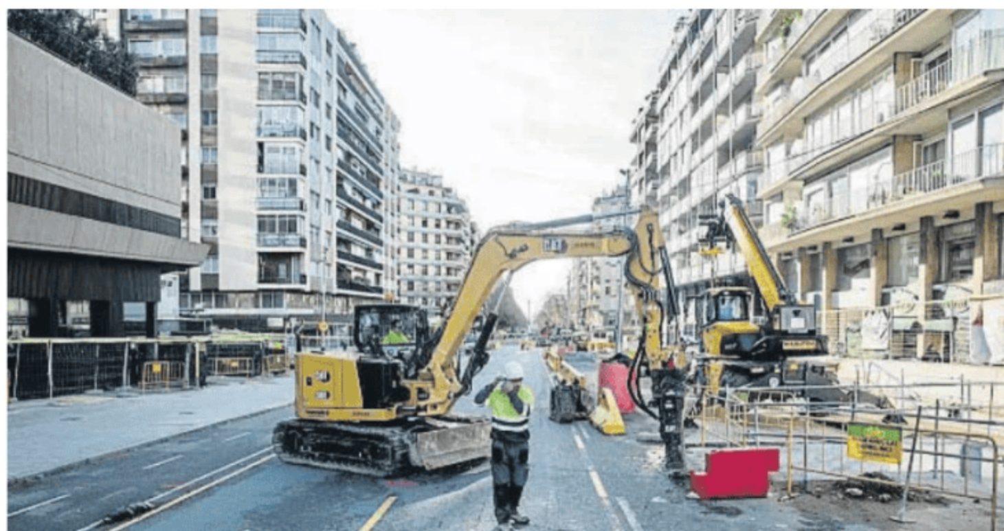
El tramo de la calle Urgell, entre Francesc Macià y la calle Buenos Aires, cerrado por obras
